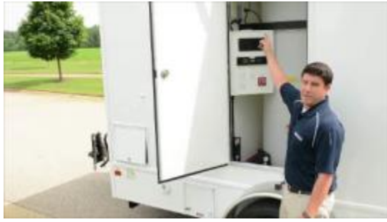
12 Volt Panel - Converter
